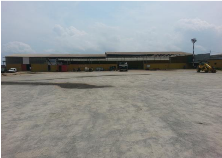
Zone de préfabrication et de stockage
