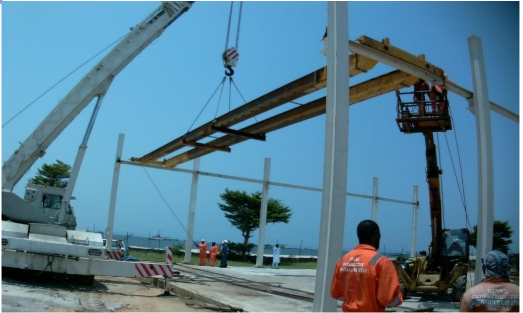
Montage d'un pont roulant de 10 Tonnes
